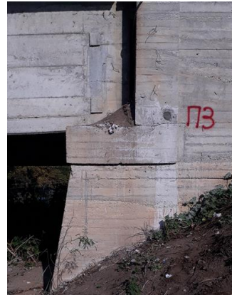
Εικόνα 10: Ακρόβαθρο-Θεμελίωση
